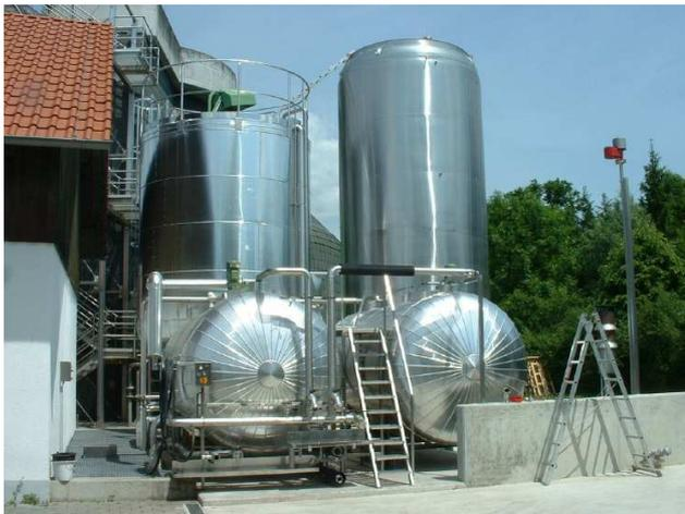
Abbildung 6.4.2: Annahmestation mit Tankbehälter der Kläranlage Moosburg (Strunkheide S.15, 2007)
