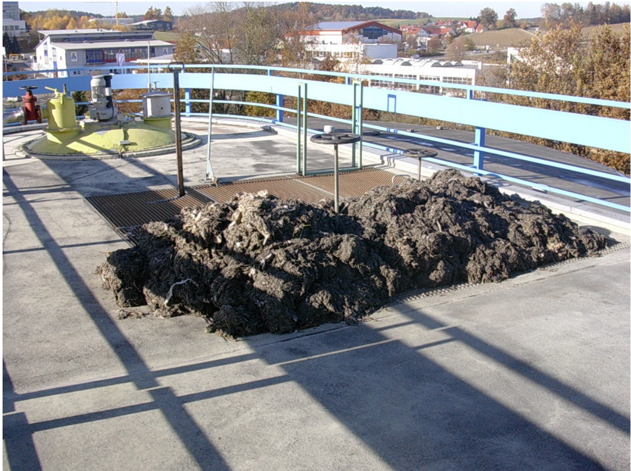
Foto 1: Herausgelöste Verzopfungen durch den Einsatz von Celluferm
