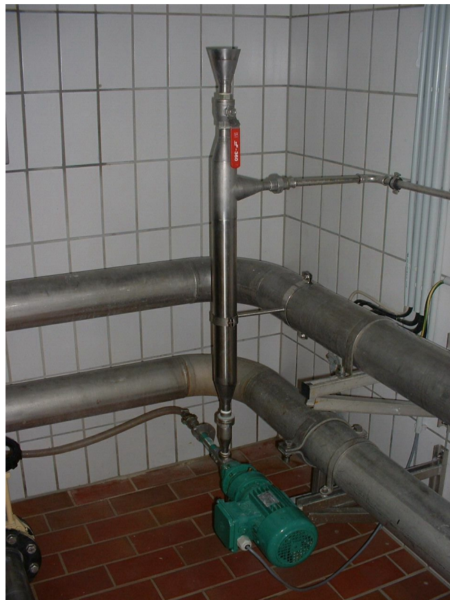
Bild 2: Celluform-Dosierstelle (Rohschlammbeschickungsleitung)
