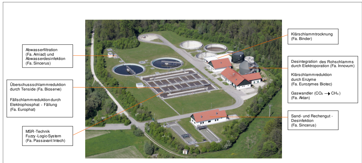
Bild 1: Realisierte innovative Technologien bei der Kläranlage Moosburg
