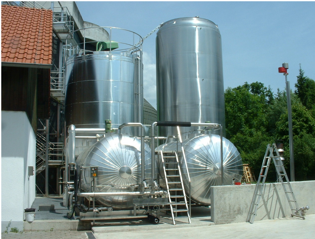
Bild 4: Annahmestation für die Co-Substrate
