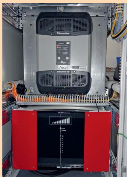
Bild 3 Lithium-Ionen-Speicher: 2 kWh Speichermodul mit Wandler in extrem langlebiger Titanat-Technologie der Fa. Leclanché GmbH (links); 9,2 kWh Speichermodul in Eisenphosphat-Technologie der Fa. Fenecon GmbH (rechts)
