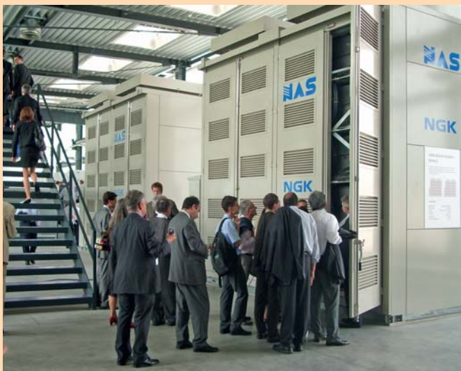
Bild 5 Natrium-Schwefel-Batterie im Testfeld bei Younicos AG in Berlin, Speicherkapazität je Turm 3,5 MWh
