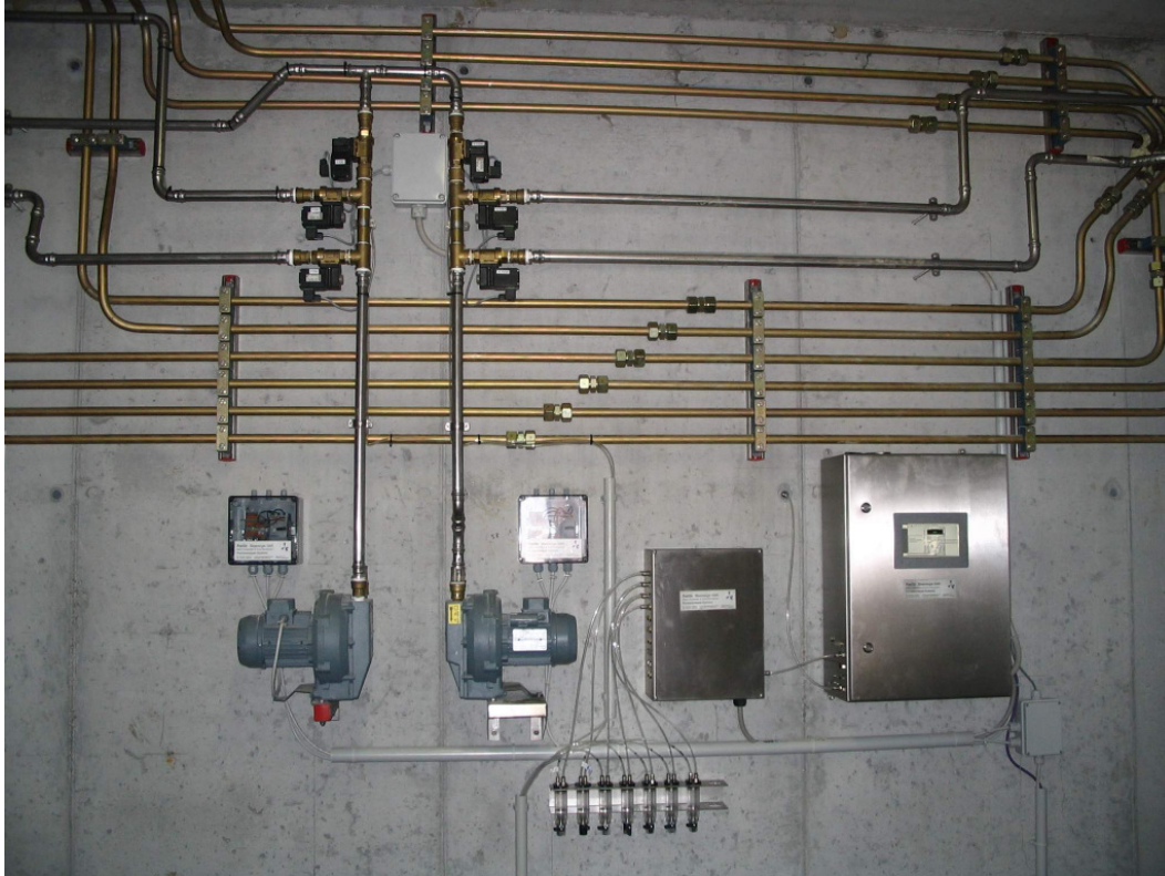
Abbildung 1 zeigt beispielhaft den Aufbau mit Online-Gasanalyse-System, Verdichter und Schaltventilen. Mit dieser Anordnung kann direkt über den Sauerstoffgehalt des Biogases dem Sauerstoffverbrauch der entschwefelnden Mikroorganismen und dem aktuellen Gasanfall Rechnung getragen werden.
